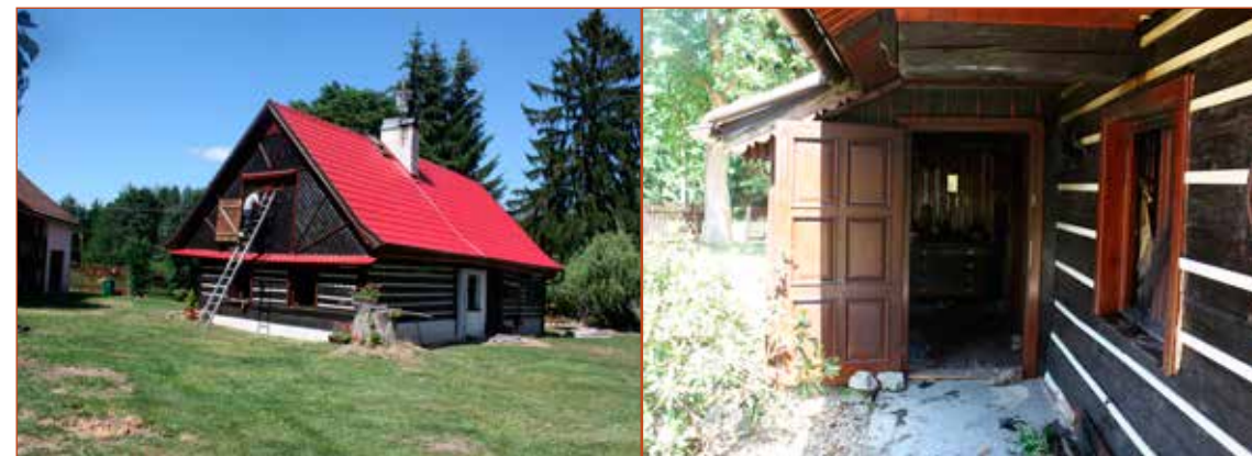
Obr. č. 1 – Celkový pohled na objekt roubenky.
