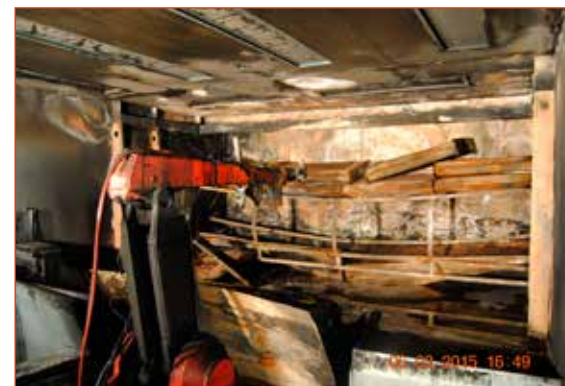
Obr. č. 5 – Automatická lakovací linka zasažená požárem - pohled z vnitřní strany (svědecké ohnisko).
