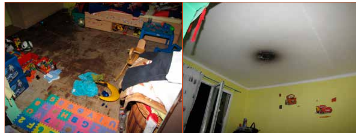
Obr. č. 1 – Stav při příjezdu vyšetřovatele požárů.
