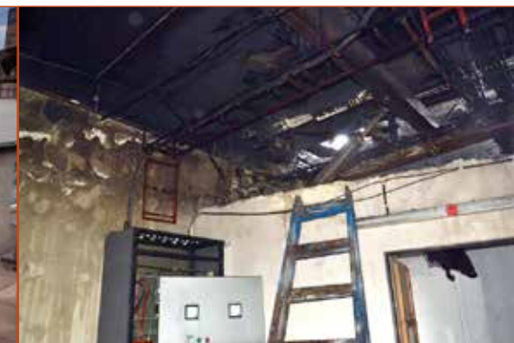
Obr. č. 2 – Místo řezacích prací.
