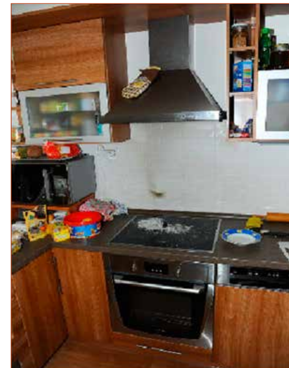
Obr. č. 1 – Kuchyňský kout se sklokeramickou deskou, na které vznikl požár.
