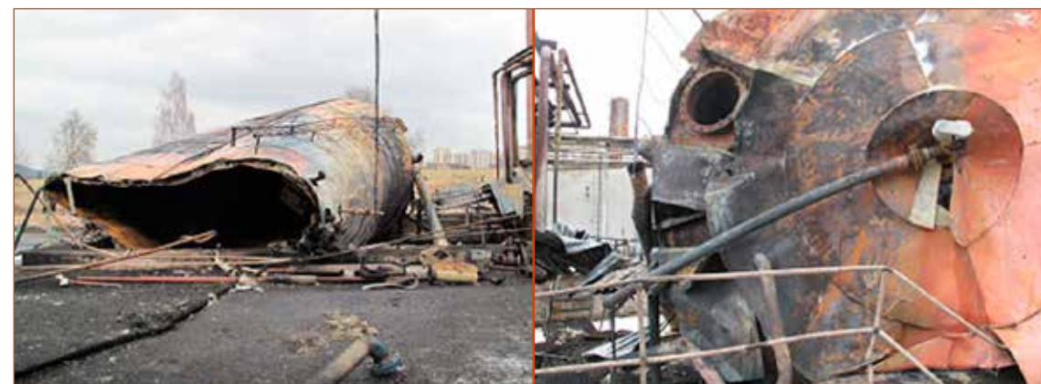
Obr. č. 5 – Levá nádrž po požáru.
