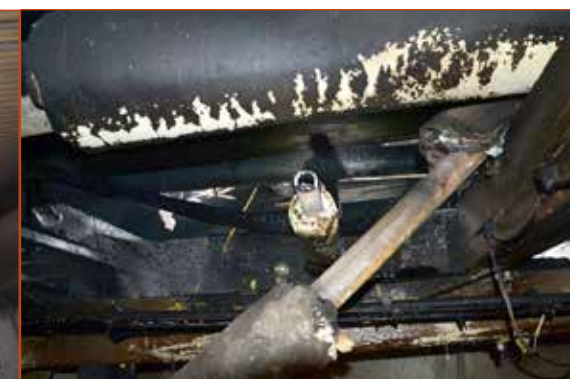
Obr. č. 4 – Řezané potrubí.
