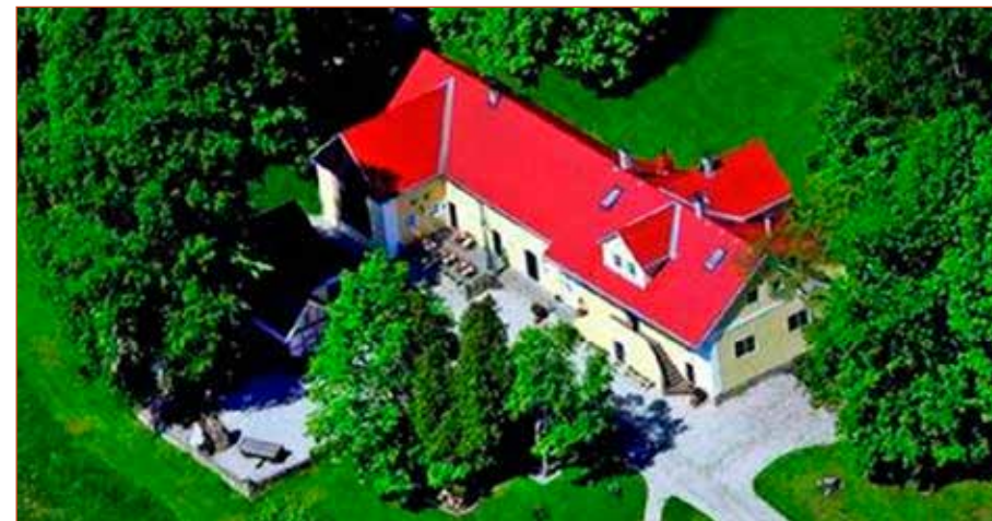
Obr. č. 1 – Celkový pohled na objekty před požárem.
