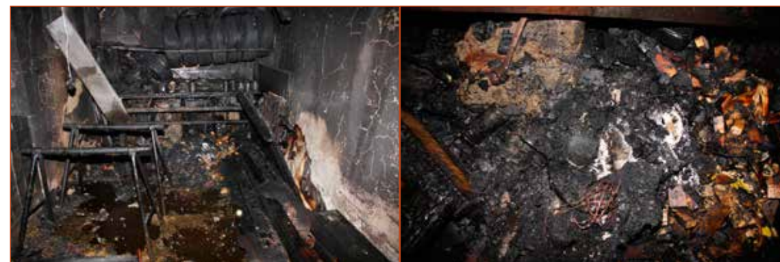
Obr. č. 3 – Celkový pohled do vnitřního prostoru s vyznačeným prostorem nálezu plechovky.
