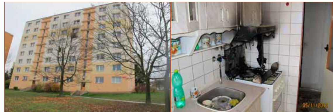
Obr. č. 1 – Celkový pohled na osmipodlažní bytový panelový dům, ve kterém došlo k požáru instalační šachty.
