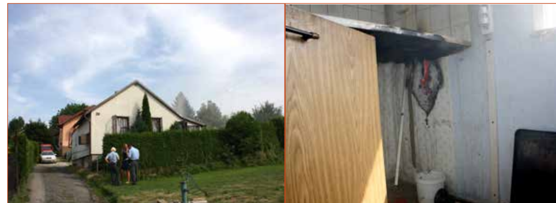
Obr. č. 1 – Celkový pohled na rodinný dům.
