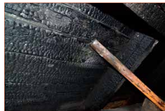
Obr. č. 5 – Styk trubky se střešní konstrukcí.
