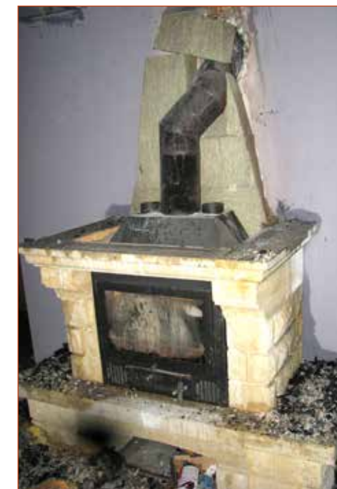
Obr. č. 2 – Topidlo se sundaným výměníkem teplého vzduchu.
