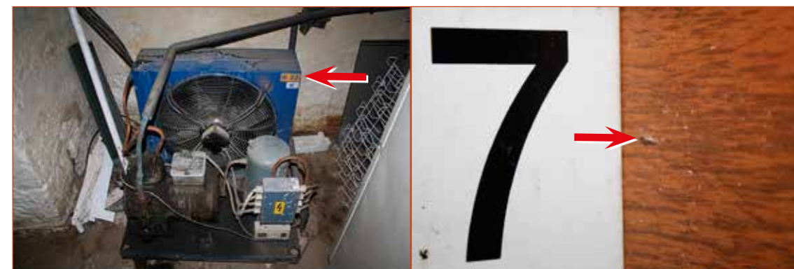
Obr. č. 5 – Kompresor chladicí soustavy (označení nesouhlasí s obsahem plynné látky).
