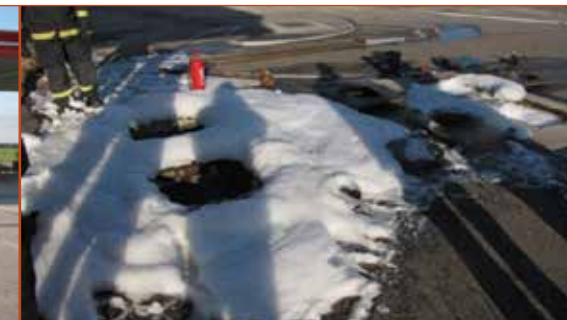
Obr. č. 2 – Pohled na šachty, kde byly prováděny práce po příjezdu vyšetřovatele požáru.
