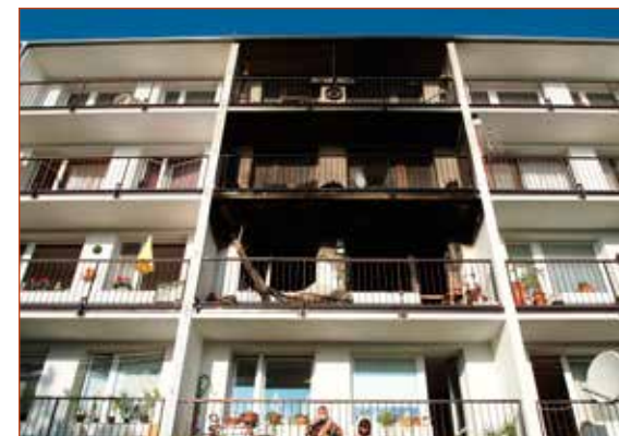
Obr. č. 1 – Celkový pohled na objekt.
