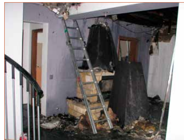
Obr. č. 1 – Těleso topidla s dvouplášťovým výměníkem teplého vzduchu.
