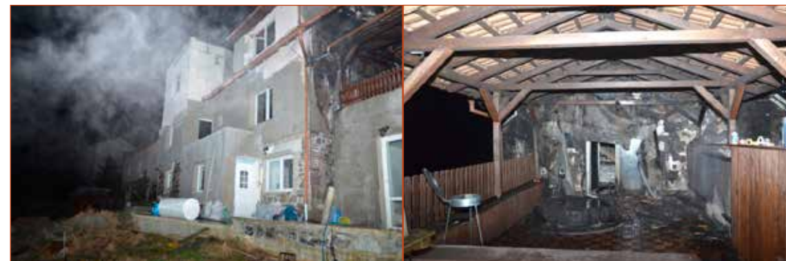
Obr. č. 1 – Pohled na třípodlažní objekt RD.
