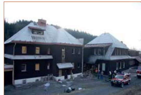
Obr. č. 1 – Celkový pohled na objekt.
