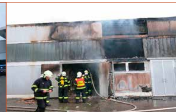
Obr. č. 2 – Pohled na objekt při požáru.
