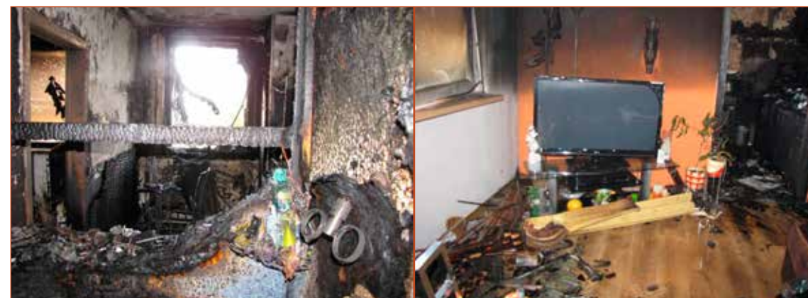
Obr. č. 5 – Záběr z bytového jádra do kuchyně.
