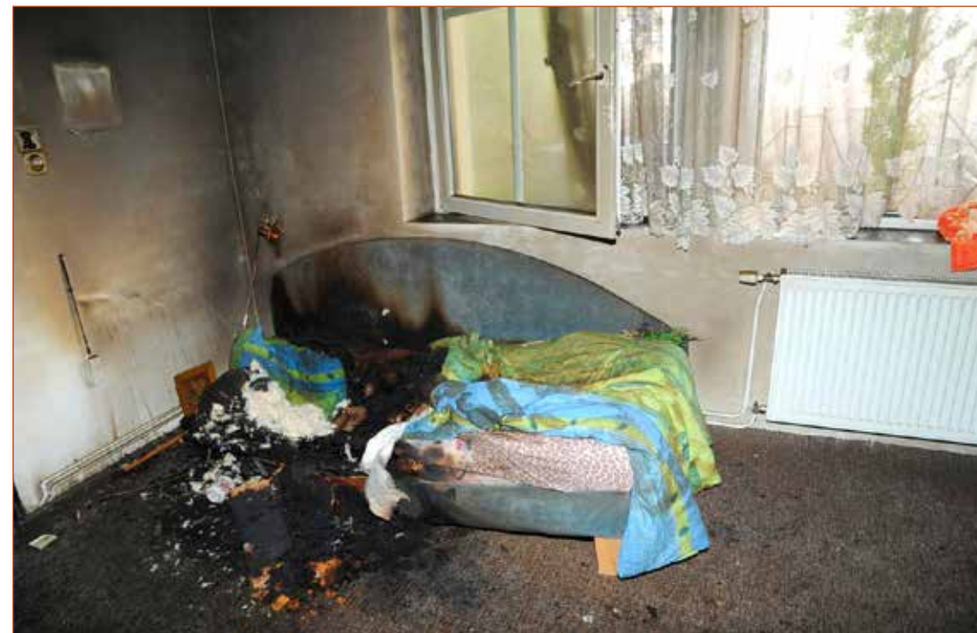
Obr. č. 1 – Celkový pohled do pokoje, kde požár vznikl.
