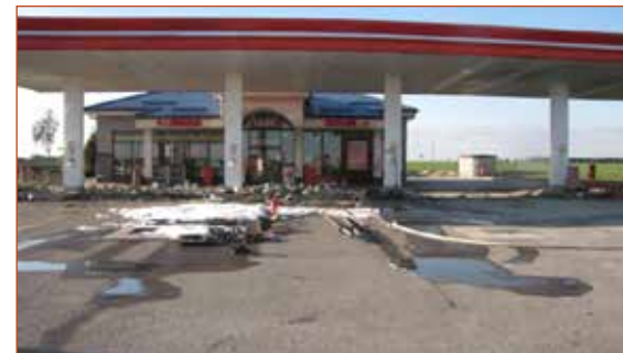
Obr. č. 1 – Pohled na čerpací stanici z jižní strany.
