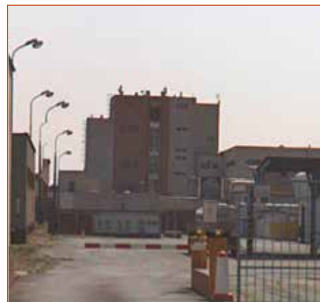
Obr. č. 1 – Pohled na objekt.
