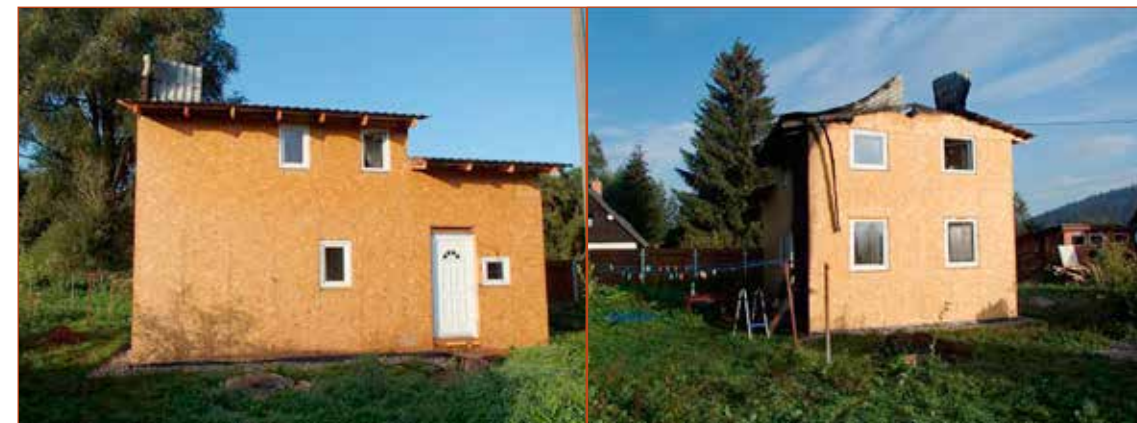
Obr. č. 1 a 2 – Celkový pohled na objekt – SV a JV stěna.
