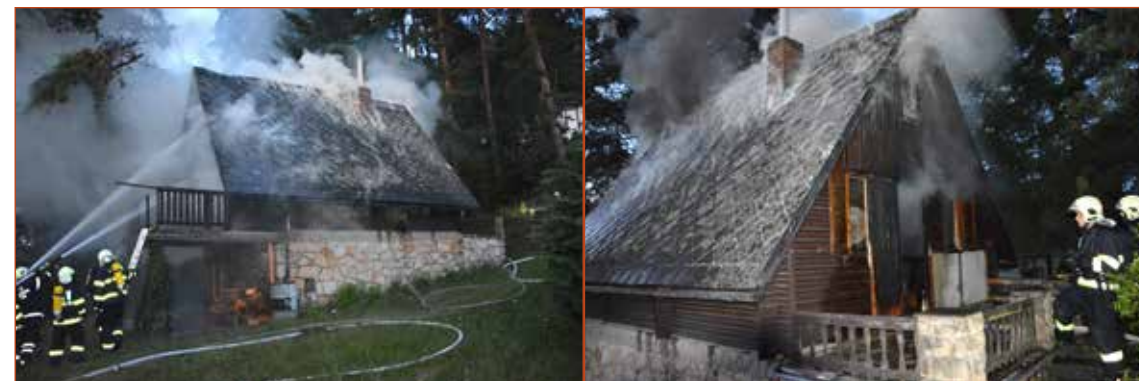
Obr. č. 1 a 2 – Pohled na požár chaty.
