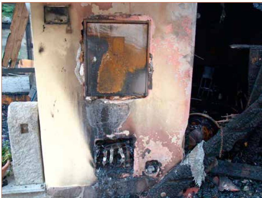
Obr. č. 4 – Jedno z kriminalistických ohnisek v pojistkové skříni u dřevěných schodů do podkroví restaurace.
