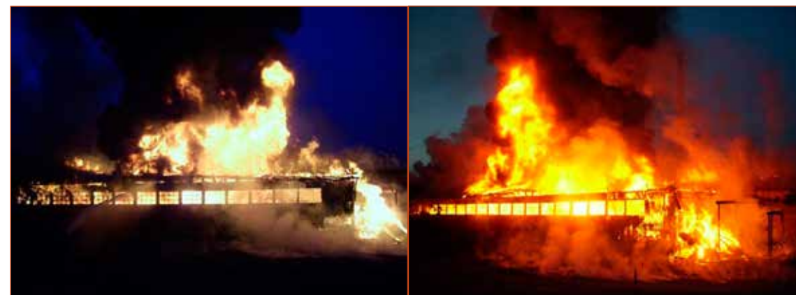
Obr. č. 3 a 4 – Skladovací hala při požáru.
