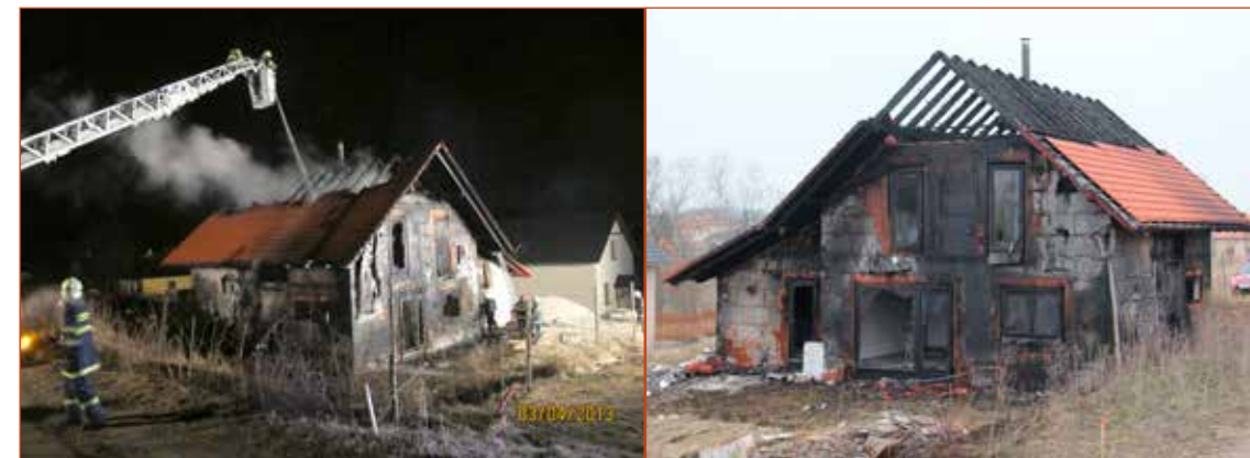
Obr. č. 1 – Celkový pohled na objekt při požáru.
