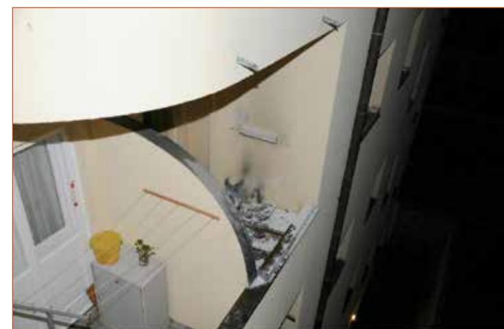
Obr. č. 2 – Pohled z balkonu, odkud byla zábavní pyrotechnika házena.
