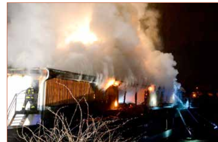
Obr. č. 4 – Pohled na požárem zasaženou dvorní část.
