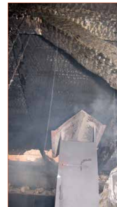
Obr. č. 5 – Detail ukončení komínu pod střešní konstrukcí.
