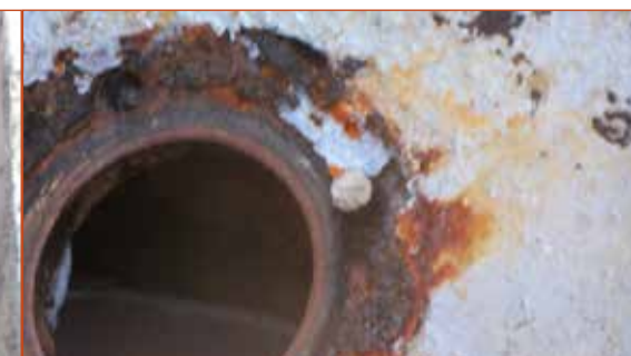
Obr. č. 4 – Detail šroubu odděleného úhlovou bruskou.
