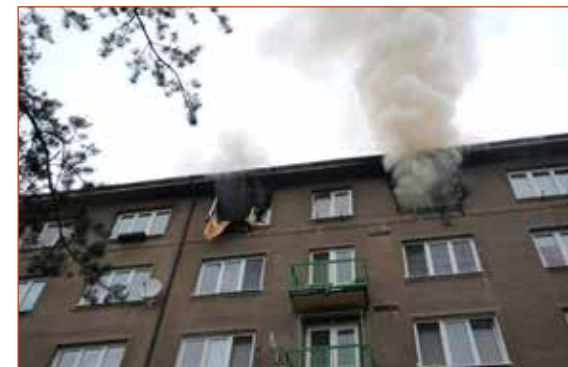
Obr. č. 1 – Detail oken bytové jednotky.
