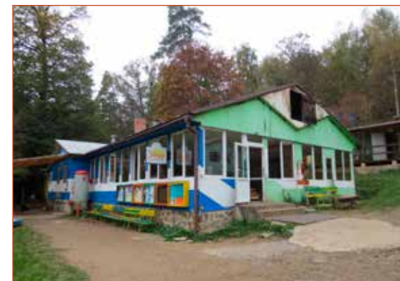
Obr. č. 1 – Pohled na objekt jídelny a kuchyně.
