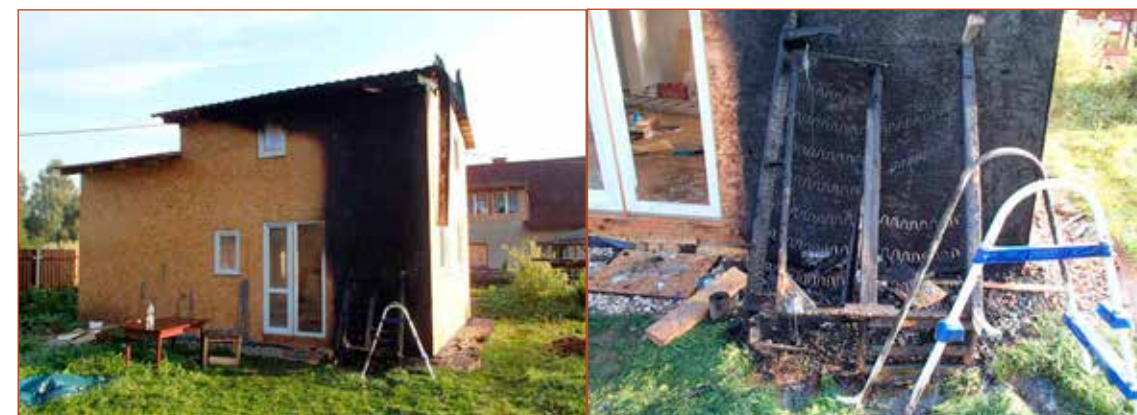
Obr. č. 3 – Pohled na JZ stěnu objektu, kde byl založen požár.
