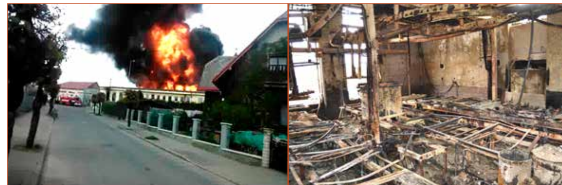
Obr. č. 1 – Objekt v době prudkého vznícení přehřátých zplodin hoření v době přibližně 250 minut po vzniku požáru, ke vznícení došlo v průběhu odvětrávání prostor po již uhašeném požáru.
