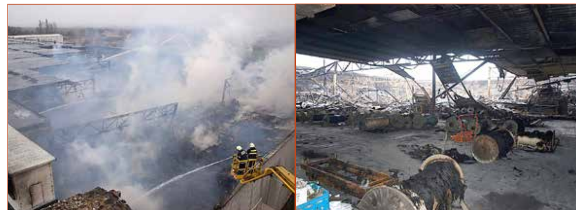
Obr. č. 3 – Probíhající zásah jednotek PO.
