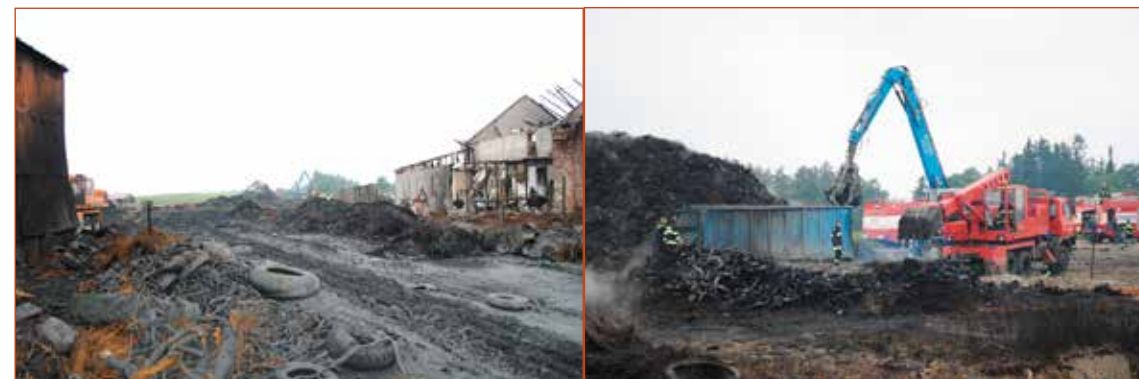
Obr. č. 3 – Pohled na prostor skládky po likvidaci požáru mezi budovami původního zemědělského areálu.
