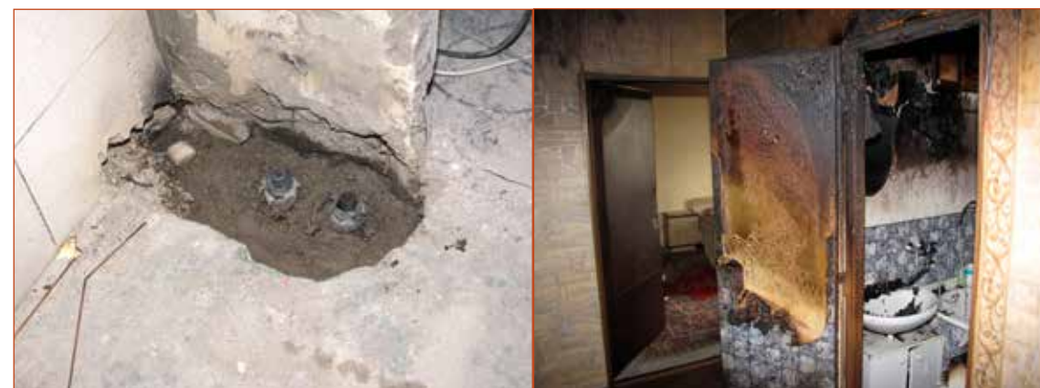
Obr. č. 3 – Detail místa řezání v bytě.
