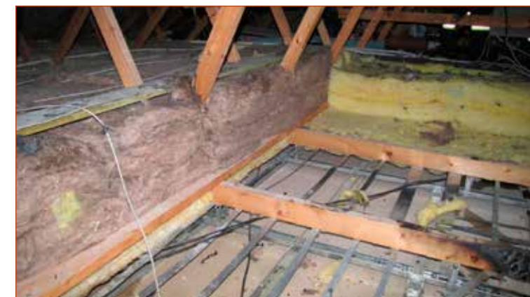
Obr. č. 4 – Detail zateplení stropní konstrukce.
