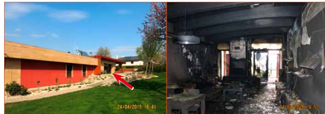
Obr. č. 1 – Celkový pohled na východní podélnou stranu rodinného domu. Okna na této straně byla pro obývací pokoj a kuchyňský kout. Šipka ukazuje na hlavní vstup do domu.
