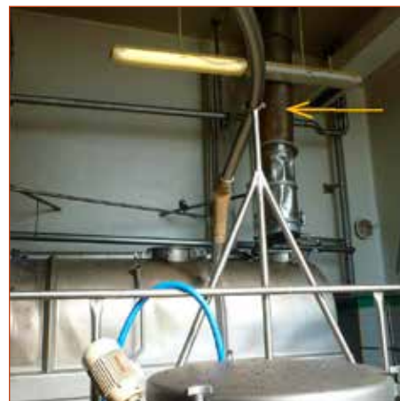
Obr. č. 3 a 4 – Označená část potrubí, ve které došlo ke vzniku požáru a pohled do daného potrubí.
