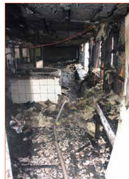
Obr. č. 2 – Pohled do dřevěné vestavby sauny s odpočívárnou.
