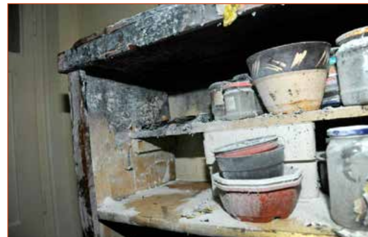
Obr. č. 1 – Požárem poškozené vybavení balkonu.
