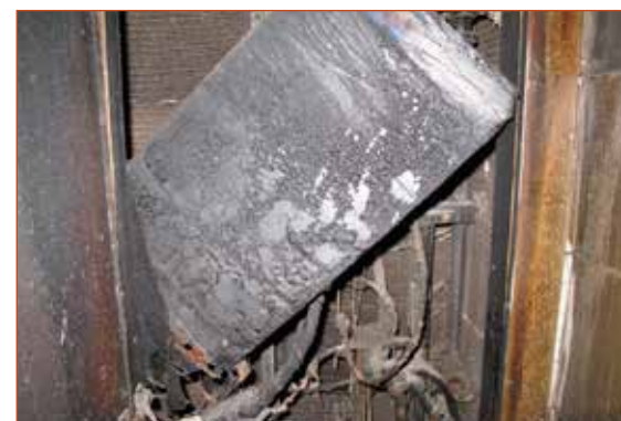
Obr. č. 5 – Instalační šachta za WC v bytovém jádru jednoho z bytů.
