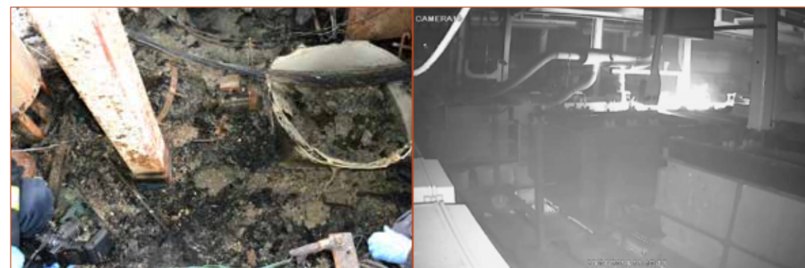
Obr. č. 3 – Místo vzniku požáru.
