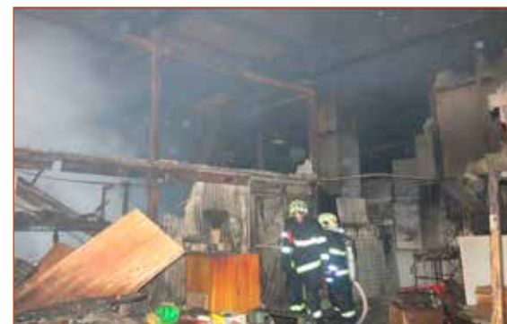
Obr. č. 5 – Požární ohnisko.
