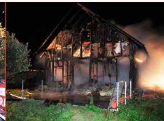
Obr. č. 2 – Pohled západní na RD při požáru.
