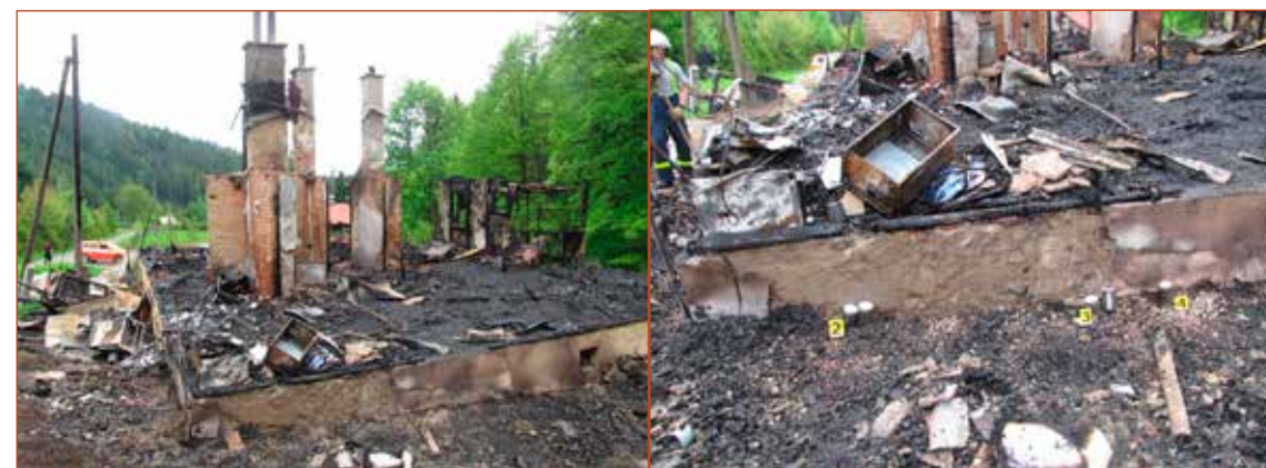
Obr. č. 3 – Celkový pohled na místo chaty po požáru před ohledáním – její celková destrukce.
