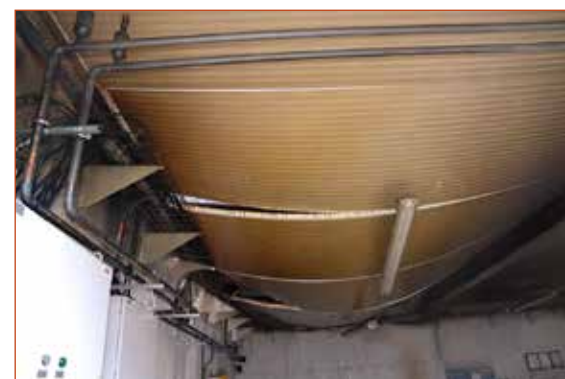
Obr. č. 3 – Stropní konstrukce nové haly.
