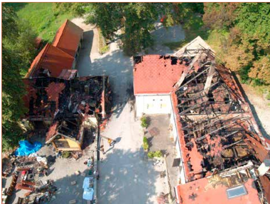
Obr. č. 3 – Celkový pohled na místo požáru z výškové techniky.
