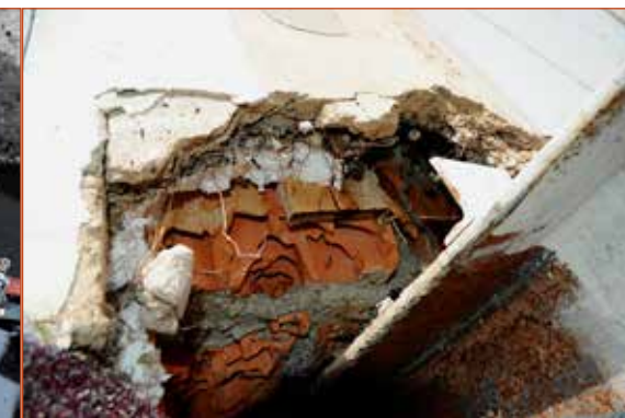
Obr. č. 5 – Skladba vnější stěny.
