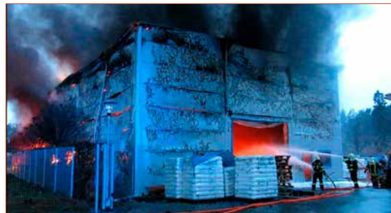
Obr. č. 1 – Požár ve III. fázi, kdy byla zasažena celá půdorysná plocha výrobní haly.
