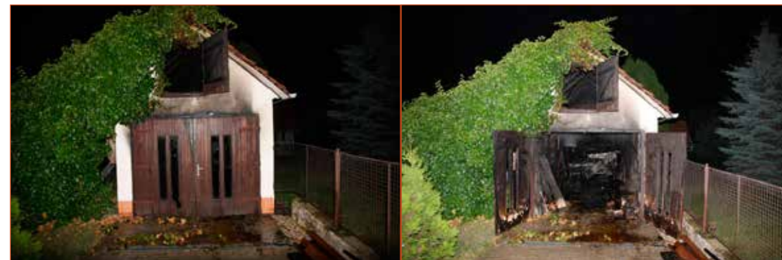
Obr. č. 1 – Celkový pohled na objekt.
