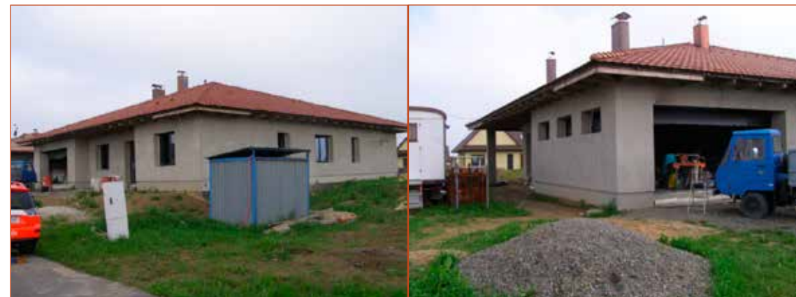
Obr. č. 1 – Celkový pohled na objekt (od příjezdové komunikace). Obr. č. 2 – Pohled na objekt (vstup do garáže).
