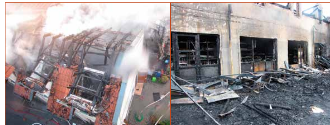
Obr. č. 3 – Pohled na místo požáru z výškové techniky.
