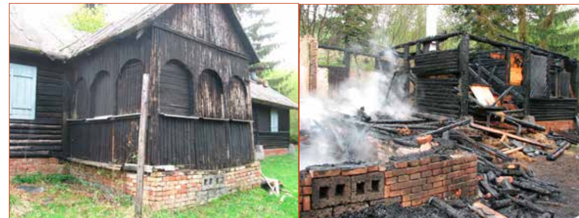
Obr. č. 1 – Celkový pohled na objekt před požárem. Obr. č. 2 – Pohled na objekt po požáru.
