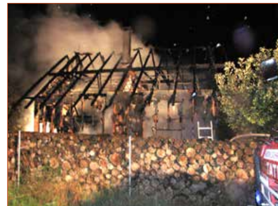
Obr. č. 1 – Pohled severní na RD při požáru.
