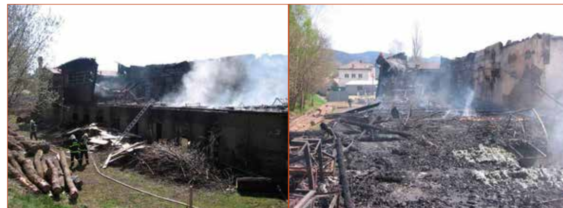
Obr. č. 5 a 6 – Skladovací hala po požáru.
