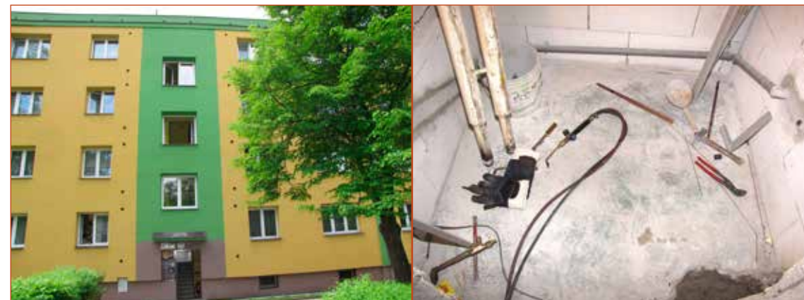
Obr. č. 1 – Celkový pohled na dům.
