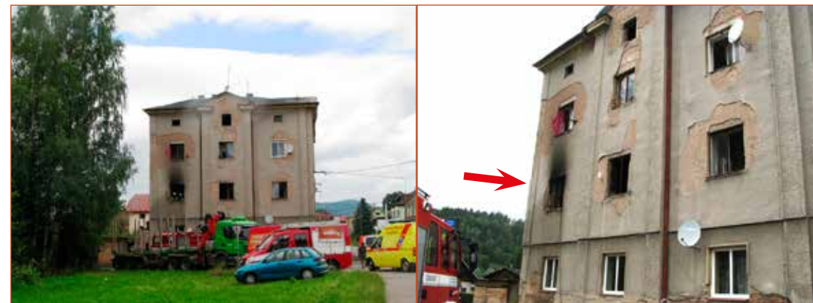
Obr. č. 1 – Celkový pohled na objekt po požáru.
