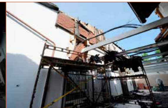
Obr. č. 3 – Místo částečné rekonstrukce.
