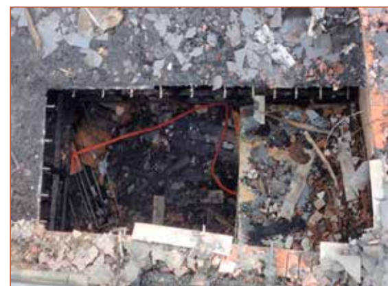
Obr. č. 4 – Pohled do nádvoří.
