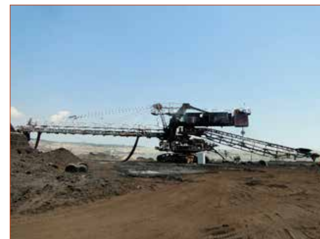
Obr. č. 2 – Pohled na objekt po požáru.
