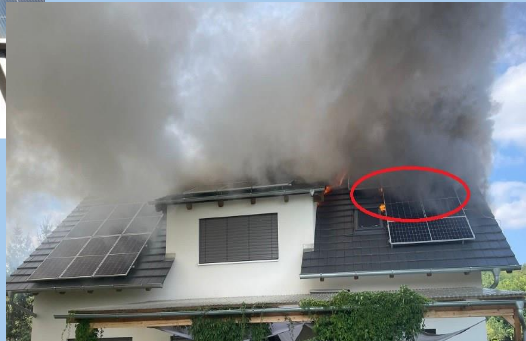
Obrázek 5: Požár FVE u nehořlavé střešní konstrukce – šíření nezastaveno
