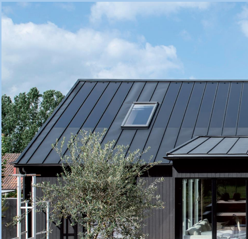
Solární panel integrovaný do střešního profilu.
