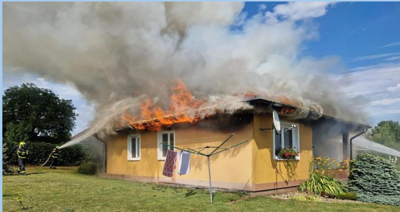
Obrázek 2: Požár střešní konstrukce způsobený FVE (zdroj: fotodokumentace HZS ČR)
